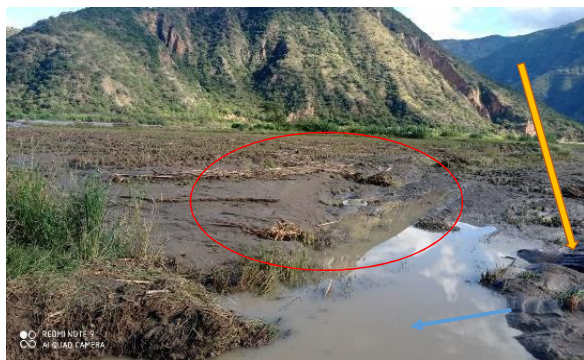
FOTOGRAFIA N°02: CANAL HUANCAS DESTRUIDO Y COLMATADO DEBIDO AL DESBORDE DEL RIO CHOTANO EN LA MARGEN DERECHA
