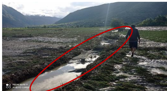
FOTOGRAFIA N°02: CANAL HUANCAS DESTRUIDO Y COLMATADO DEBIDO AL DESBORDE DEL RIO CHOTANO EN LA MARGEN DERECHA
